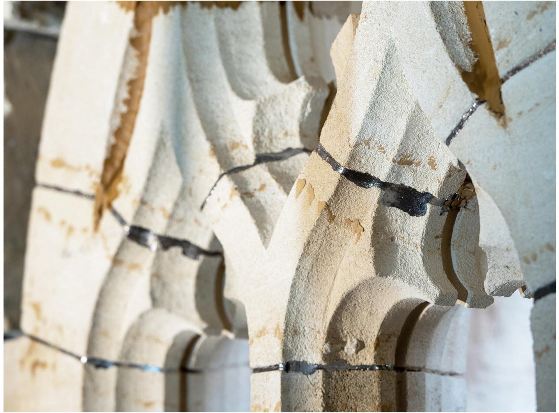
Technique traditionnelle de la coulée de plomb pour réaliser les joints. © Sunmetron / Imagine Création
