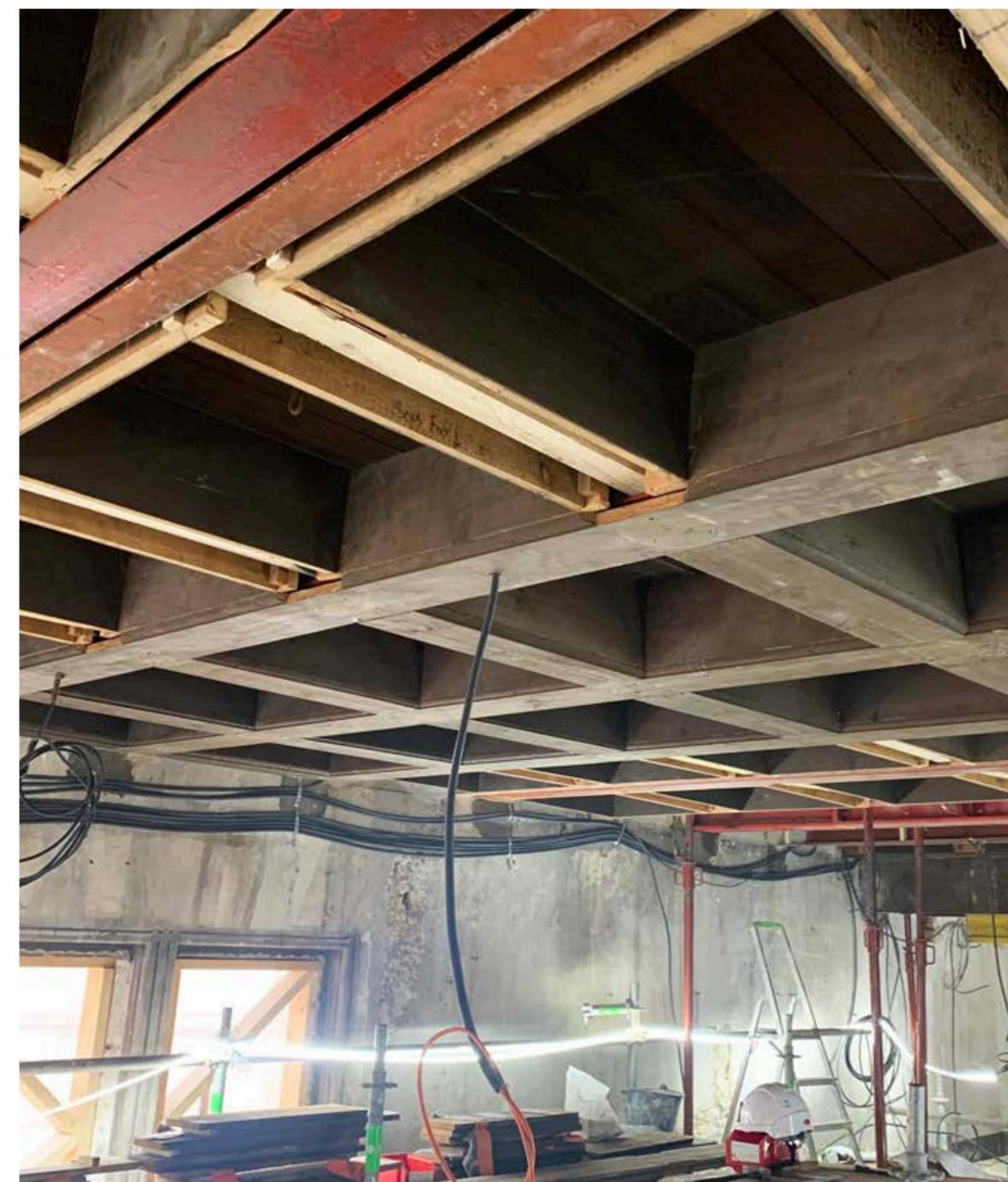
Renfort du plancher entre salle Renaissance et Mosquée. © Sunmetron
