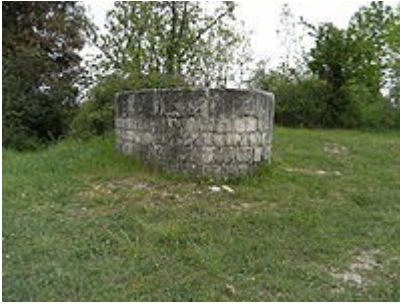
Cheminée du puits d'aération
